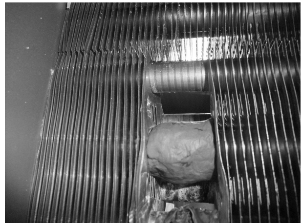
写真 3 パテによる補強
